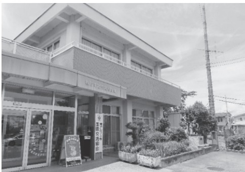
南アルプス市櫛形社会福祉会館
